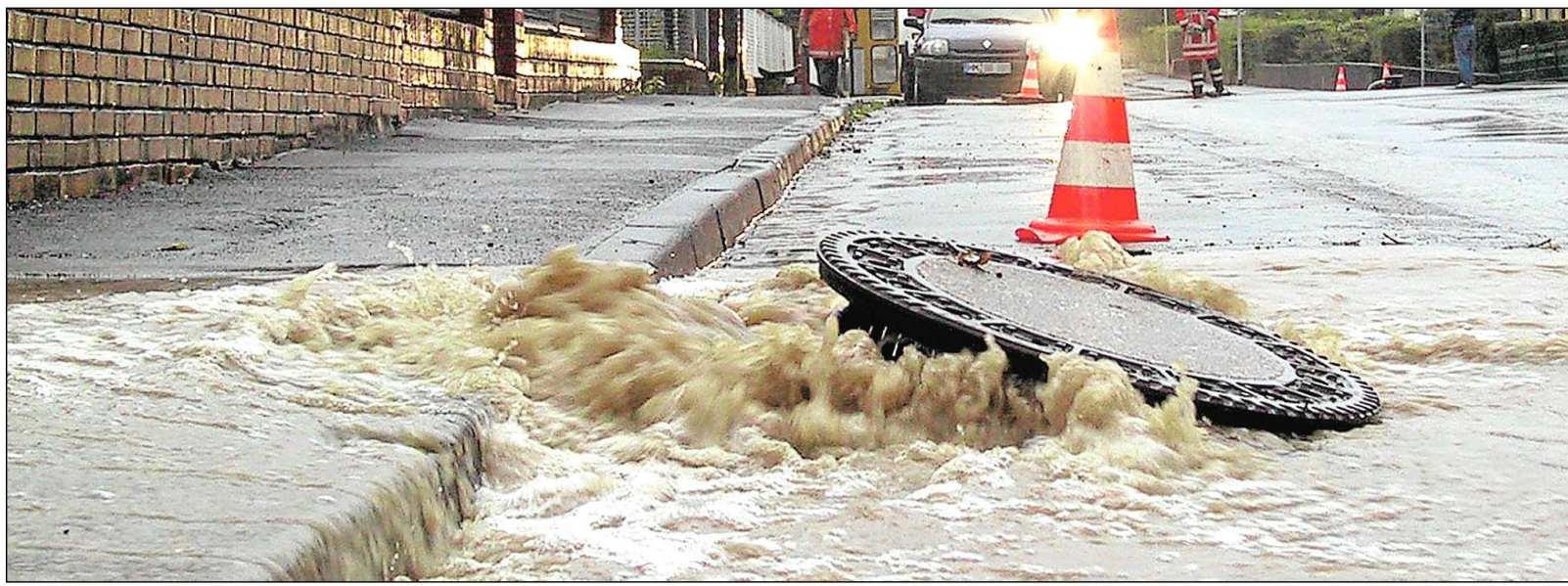
Eine Überlastung der Kanalisation kann die Folge von maroden Hausanschlüssen sein. Ein Gesetz schreibt vor, dass Hauseigentümer ihre Anschlüsse im Rahmen einer so genannten Dichtheitsprüfung untersuchen lassen müssen. In Rietberg soll das bis 2022 passieren. Die Stadt wird alle Betroffenen schriftlich informieren. Bilder: Tiemann (2)/dpa
