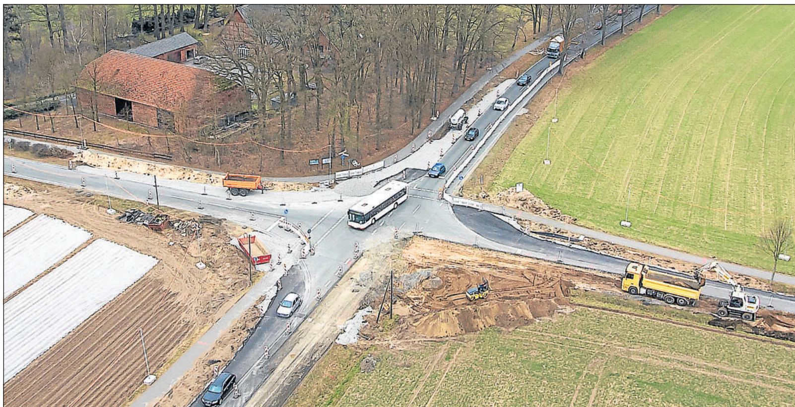
Die runde Form ist schon zu erahnen: An der Kreuzung Hauptstraße/Gütersloher Straße in Varesell wird derzeit ein Kreisverkehr gebaut. Die Ampel ist abmontiert worden. Unser Bild zeigt die Kreuzung aus der Vogelperspektive. Rechts geht es auf der Hauptstraße nach Varesell, links nach Wiedenbrück, unten auf der Gütersloher Straße nach Neuenkirchen und oben nach Gütersloh. Bild: Ulli Heukamp
